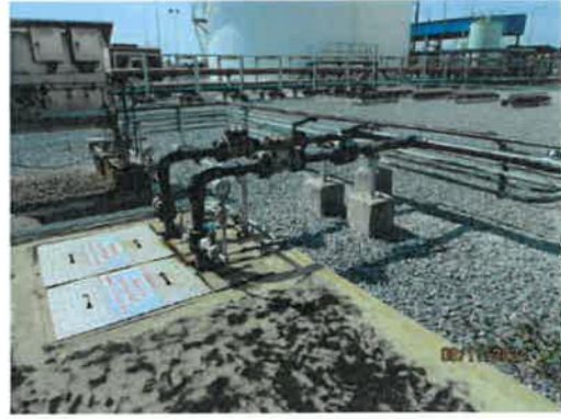
ภาพที่ 2. 2-10 บ่อตรวจสอบคุณภาพน้ำทิ้ง พร้อมวาล์ว ของโรงไฟฟ้า
