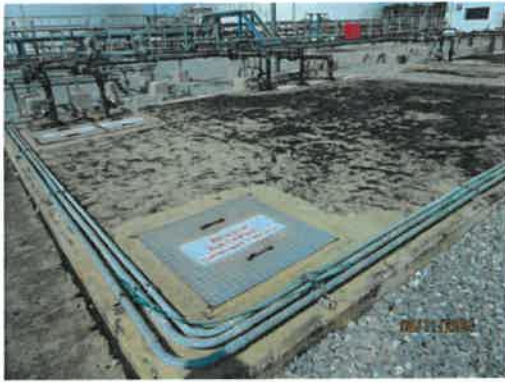
ภาพที่ 2. 2-10 บ่อตรวจสอบคุณภาพน้ำทิ้ง พร้อมวาล์ว ของโรงไฟฟ้า
